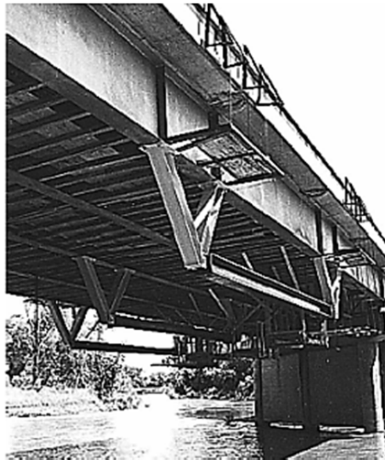
شکل الف-۵۰- میراگر روزنه متغییر نصب شده بر روی پل اینتر استیت در اکلاهما
