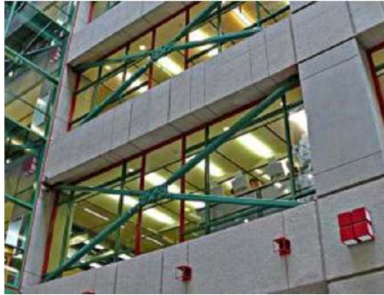
شکل الف-۳۵- میراگر اصطکاکی صرفاً کششی مورد استفاده در دانشگاه گنجدیا
