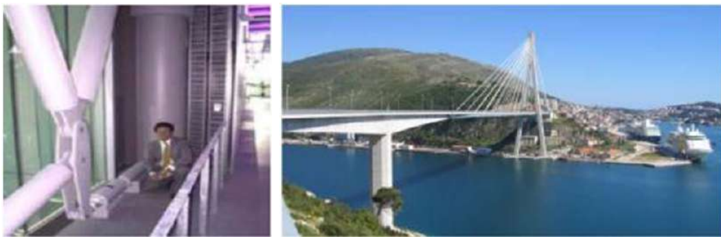
شکل الف-۵۶- پل کابلی Dubrovnik، تقویت شده با میراگر MR در سال ۲۰۰۶ میلادی
