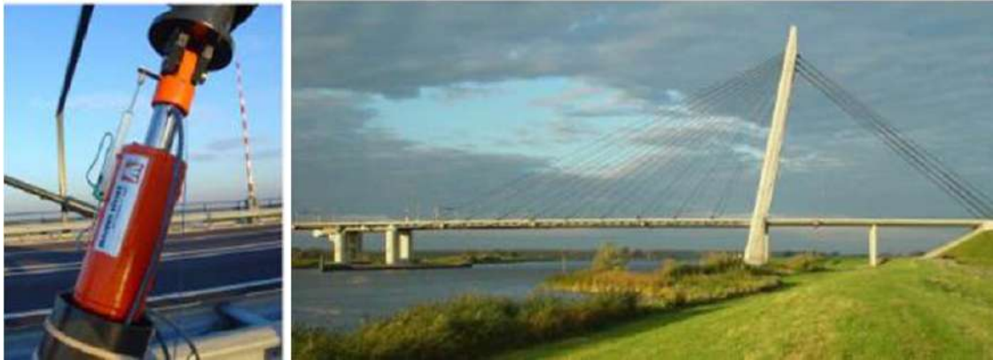
شکل الف-۵۵- پل کابلی Eiland، واقع در هلند، تقویت شده با میراگر MR در سال ۲۰۰۴ میلادی
