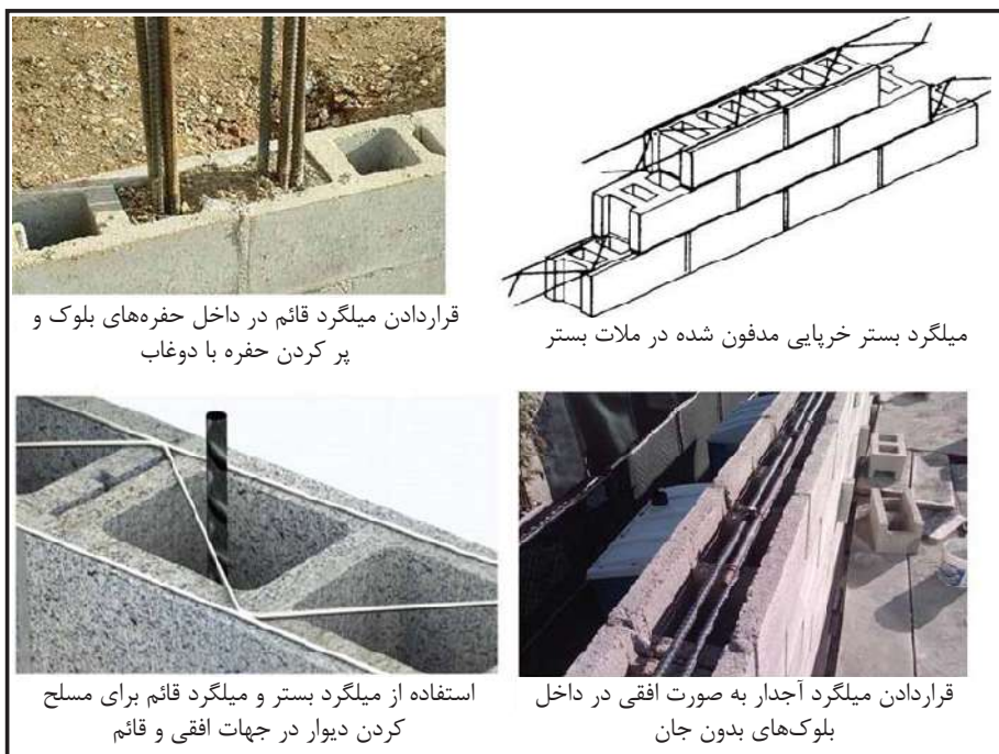
شکل پ.۴-۵- دیوارهای بنایی مسلح
