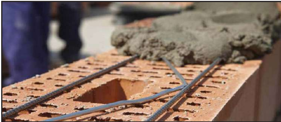
شکل ۳-۱- میلگرد بستر خرپایی قبل از پخش کردن ملات بستر بر روی آن
