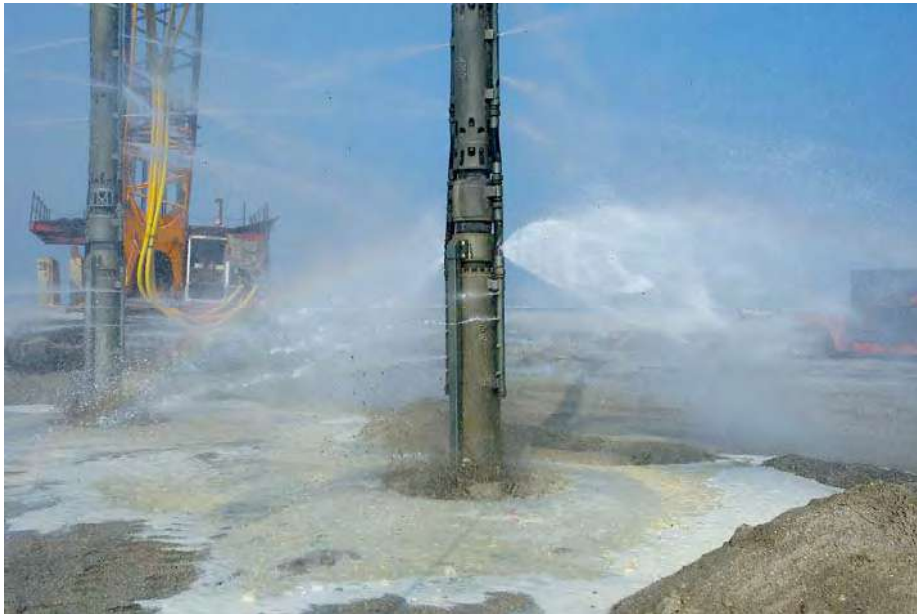
شکل ۸-۶- وسیله‌ی ارتعاشی میله‌ای شکل مورد استفاده در تراکم ارتعاشی
