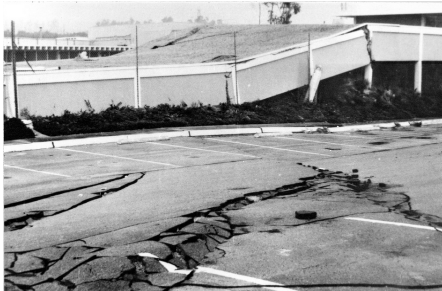
شکل ۱-۹- تغییر مکان زمین ناشی از گسترش جانبی در منطقه‌ی Juvenile Hall در طی زلزله‌ی San Fernando
