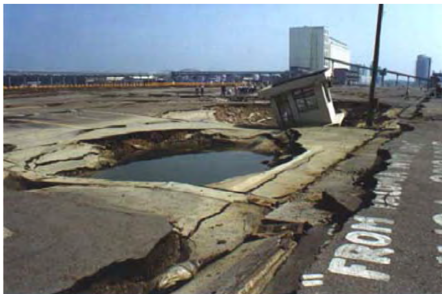
شکل ۱-۱۶- ایجاد حفره و تغییر شکل زمین پشت دیوار ساحلی در بندر Taichung در زلزله‌ی Chi Chi
