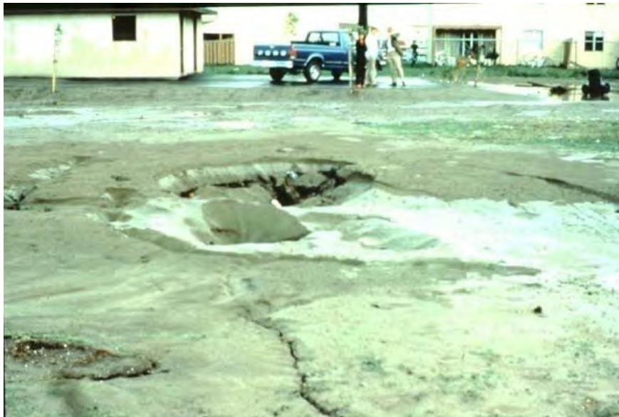
شکل ۱-۱۱- ترک‌خوردگی زمین و جوشش ماسه در جزیره‌ی Treasure در زلزله‌ی Loma Prieta
