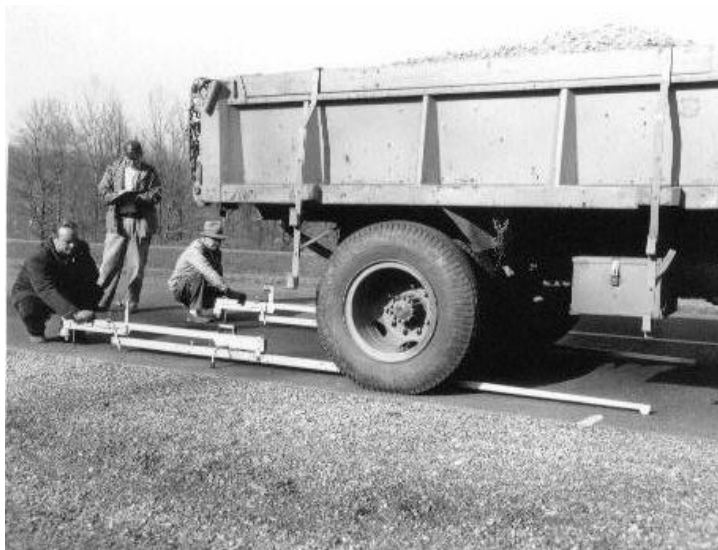
شکل ۲- تیر بنکلمن در آزمایش بزرگ آشتو
